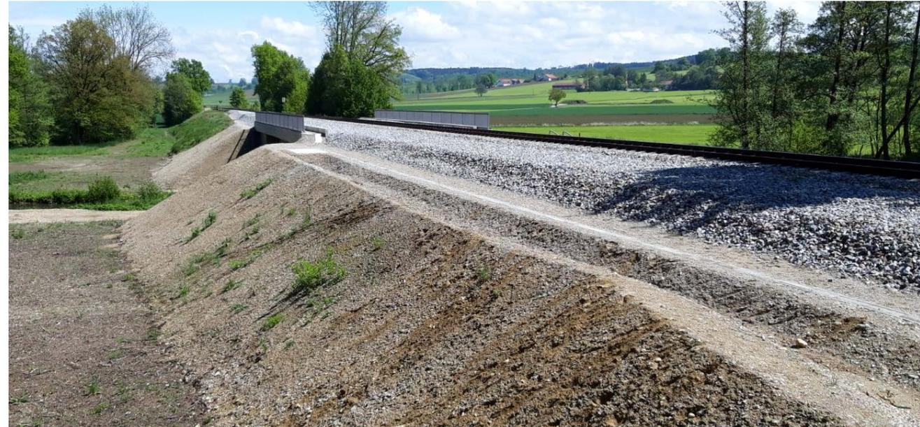
**Bild 3: Zweigleisiger Streckenquerschnitt auf Erdkörper
