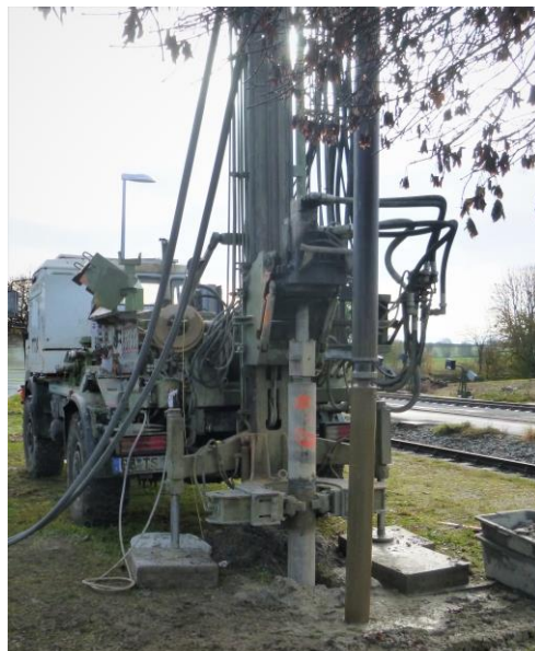
Erkundungsbohrung in Tittmoning 2019 (Foto DB AG)
