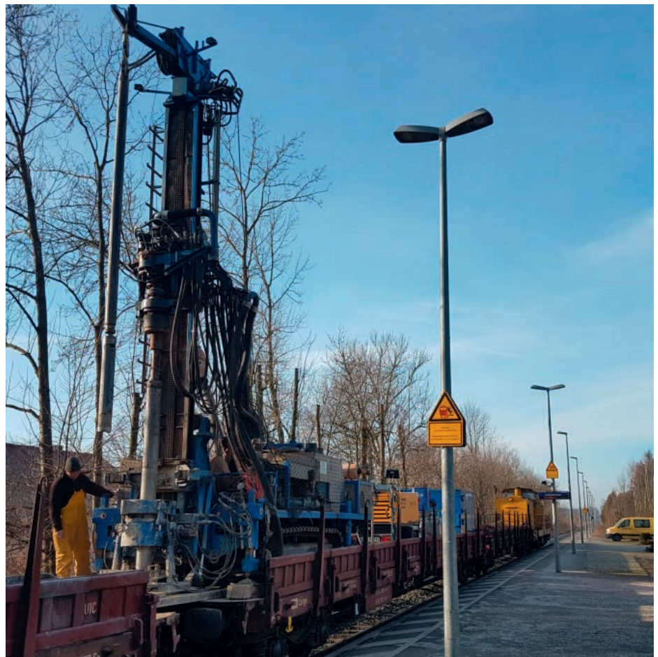
Bohrungen zur Untersuchung des Baugrundes im Gleis zwischen Markt Schwaben und Ampfing
